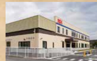
2018年竣工的榛名工厂3号楼
